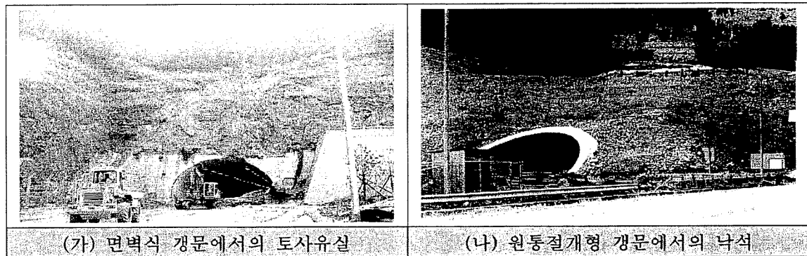
그림 3. 터널 갱문부에서의 토사유실 및 낙석
