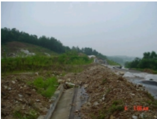
그림 4. 공장부지 조성 및 부대 토목시설물
