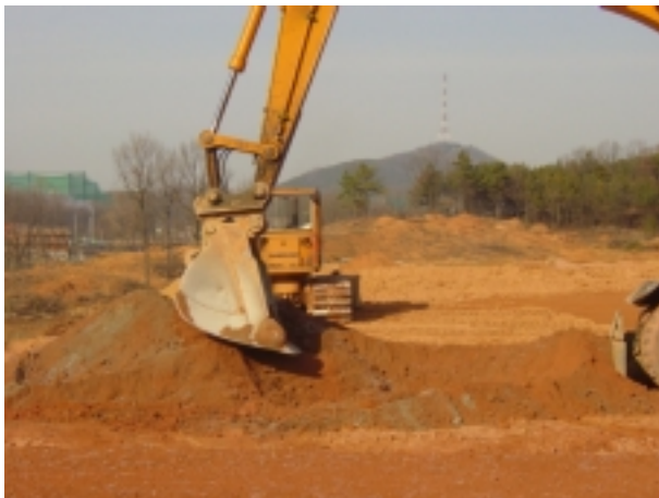
그림 1. 시멘트 및 보강재 혼합
