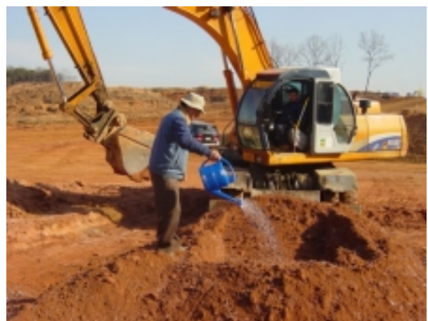
그림 2. 고화제 살포 및 혼합
