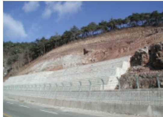
그림 3. 붕괴후 대책공법 시공사진
