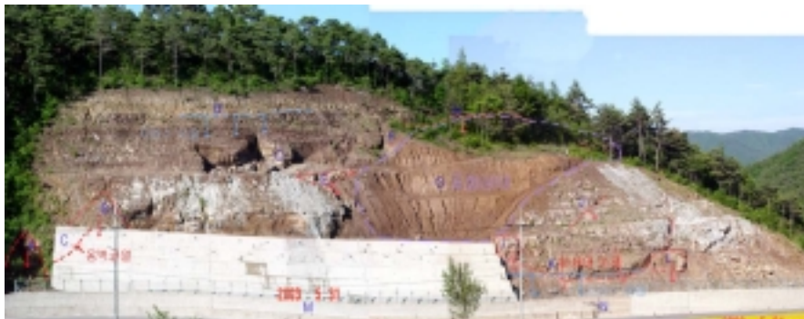
그림 6. 절토사면 계측기 설치 전경사진
