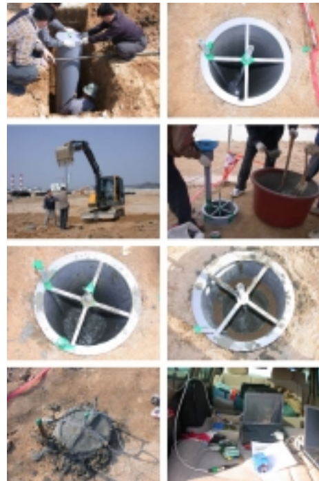
그림 6. 그라우팅 모형 설치 과정
