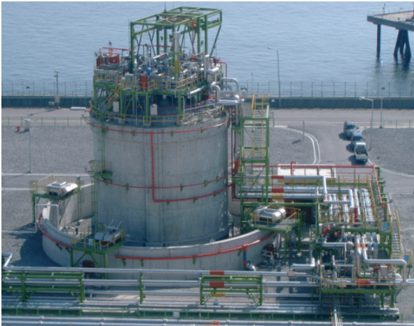
Fig.1 Pilot LNG Storage Tank
