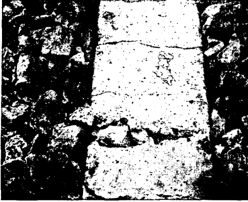
그림 4. 콘크리트 침목 손상부
