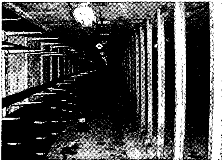
그림 1. 공동구의 내부 시설
