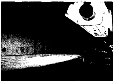
그림 2. 조명기구 설치 상태
