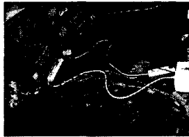
그림 17. 2개의 이동형 멀티콘센트를 연결하여 사용하고 있는 실제 일례
