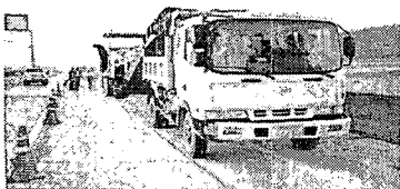
그림 5. 절삭작업 (Cold Milling + Water Jet)
