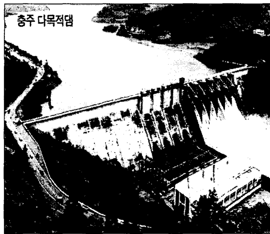
<그림 2> 충주 다목적댐 전경
