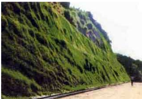
<그림 3.3> 절개지사면의 Mattress/Filter
