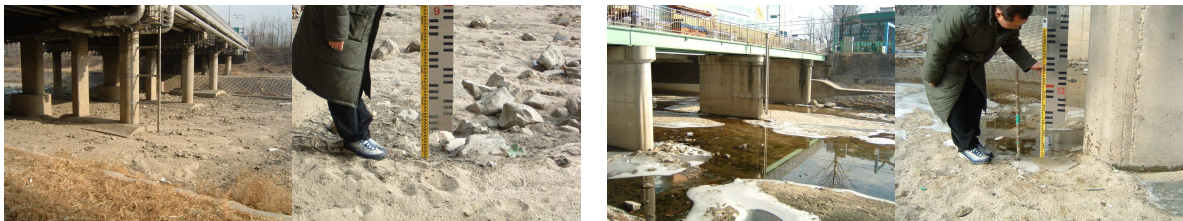
(a) 제2마장교 (전경) (b) 제2마장교 (근경) (c) 용두교 (전경) (d) 용두교 (근경)
