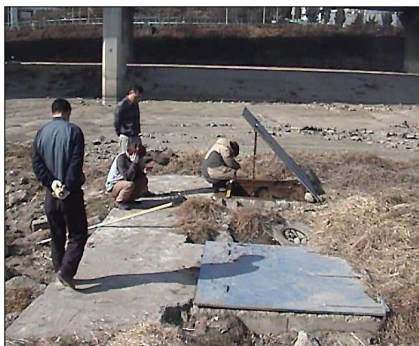
그림 3. 하수관거에서의 하수량 측정
