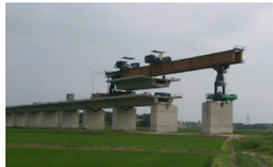
그림 10. 이동식 가설장비 (Launching Gantry)
