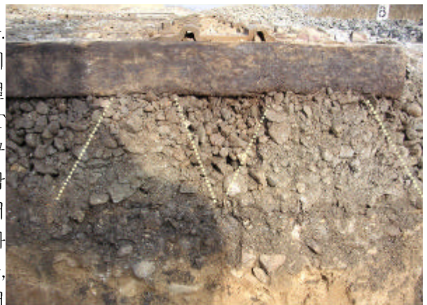
그림 3. MTT작업에 의한 도상파쇄 형상
