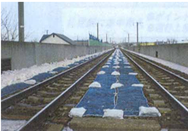
그림 1 자갈 네트 설치 운영 사례 (JR 호카이도)
