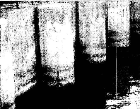
그림 6 배수갑문 : 염해/황산염의 장기 침식과 팽창에너지→표면 마모
