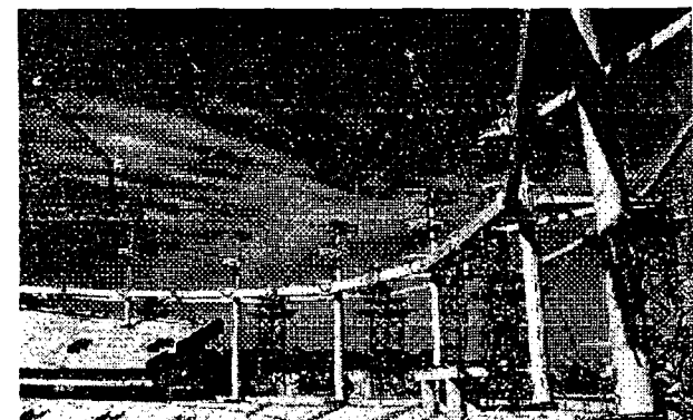
그림 3.7 Upper Radial Cable 인장
