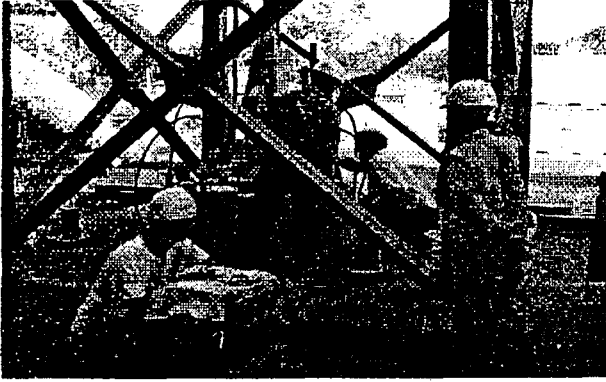
그림 3.8 Vertical Back Stay Cable 1차 인장
