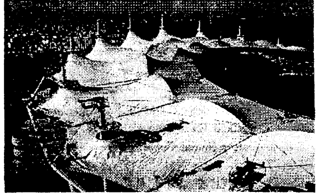
그림 3.12 막 펼치기 완료 및 막 클램핑
