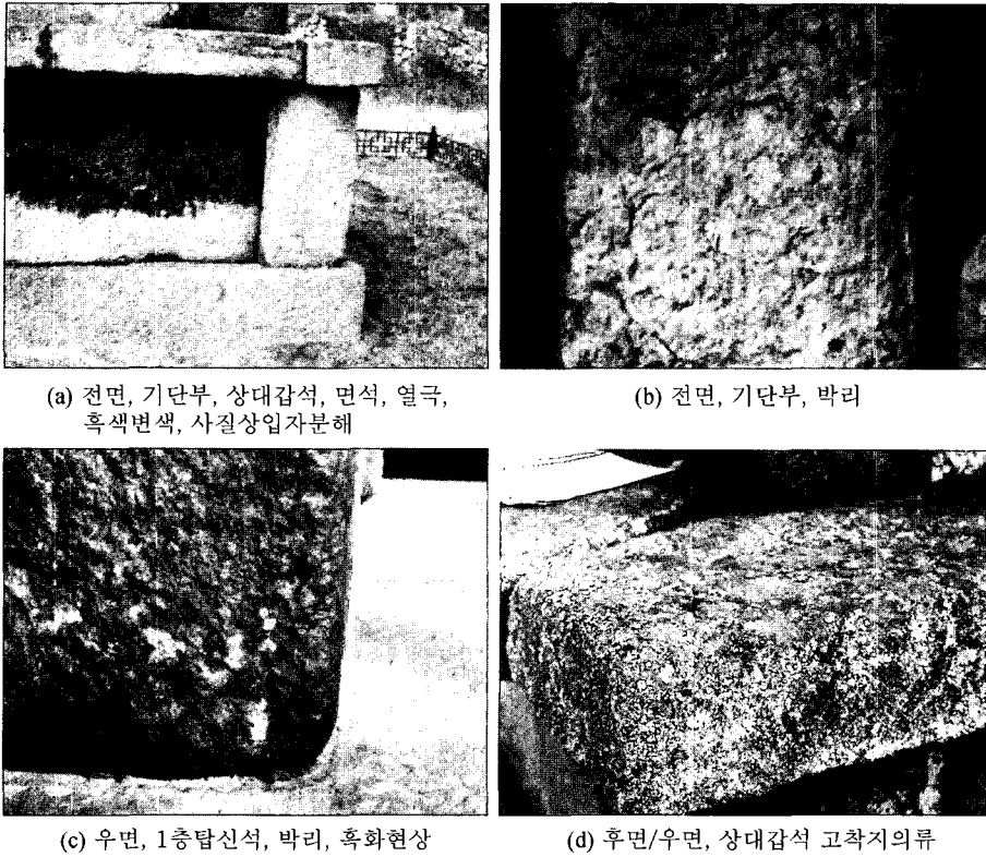
그림 2. 육안관찰에 의한 손상현황.
