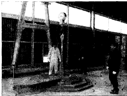
사진 5. 고체폐기물처리용 캐스크 안착 장치 설치.
