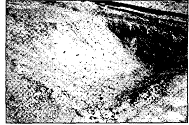
그림 4. 굴착 후 타겟설치 모습
