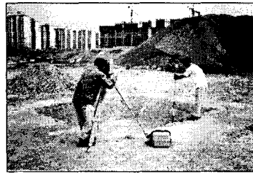
그림 6. T.S를 이용한 지형측량
