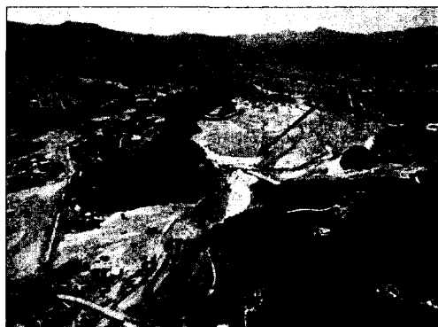
(d) 저수지 붕괴후 촬영된 사진
