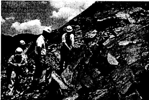
그림 8. (좌) 사면활동부 활동암괴중 발파암 노출구간, 대부분 판상으로 나타난다. (우) 완전풍화된 암맥의 상세, 암맥의 노출폭은 150cm 내외이며 습윤상태이다.
