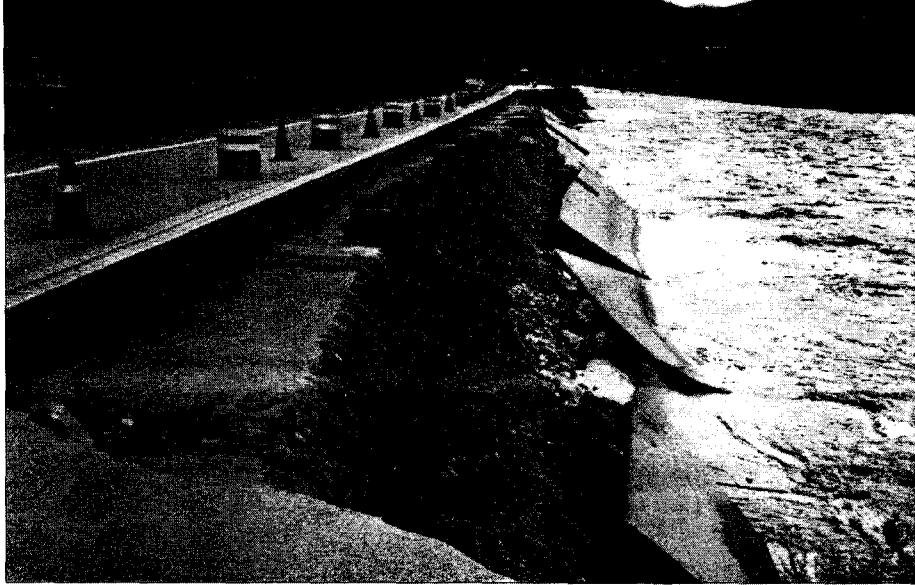
그림 3.10 슬라이딩 발생 사례(88고속도로, 2002.8)
