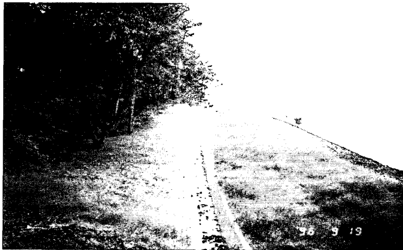
그림4.4 산마루측구 설치 예
