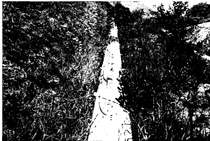
그림 3.14 소단배수로의 설치 예
