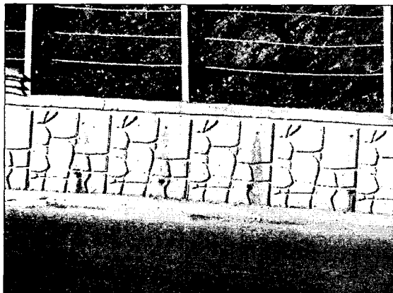
그림 2. 오염된 L형 측구와 절개면 법면에 피복된 침전물
