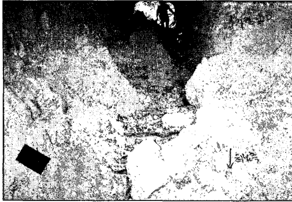
〈그림 2-2〉 ○○터널 사갱 붕괴 사고 전경 (좌 : 사갱 전경, 우 : 붕괴 선단부 콘크리트 라이닝 및 지반상태)
