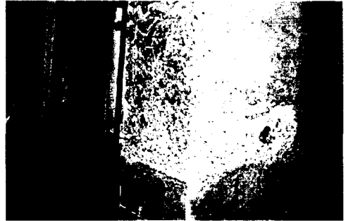
그림 6 충전불량으로 인한 재료분리 현상
