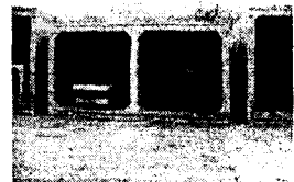
c) 수로 box culvert
