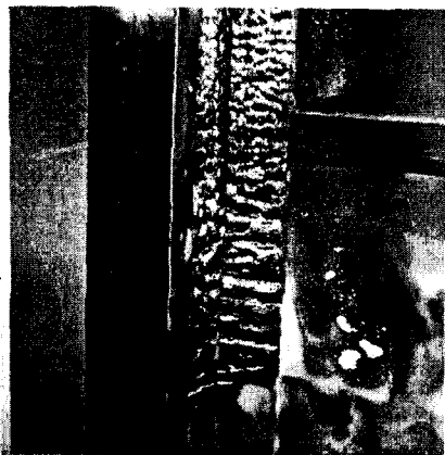
그림 10. 스토브 인접 우각부에 설치된 코너기둥의 연소현황 확대사진
