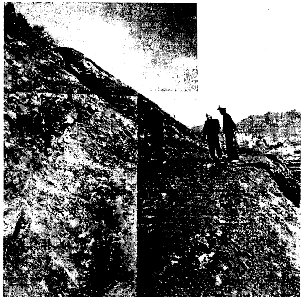
그림 2. 편마암 사면의 단층으로 인한 붕괴사례
