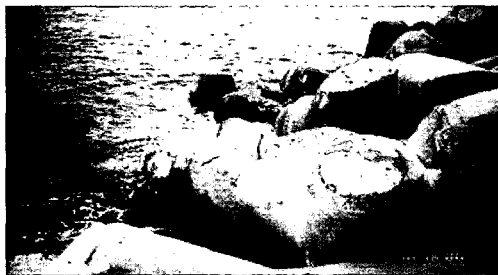
Fig. 7. Damage of T.T.P
