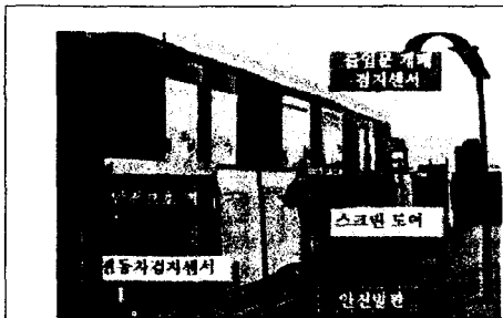
사진 1. 전동차 고상 홈 승강장에 개발품 적용모습
