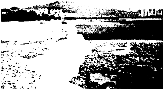
그림 36. 장비의 통행성 확보를 위한 토목섬유, 산토복토 및 샌드매트 포설(1998, 과양항 중마매립지)
