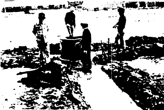
그림 7. 집수정 설치 및 집수정내의 물의 양수작업(적현단지)
