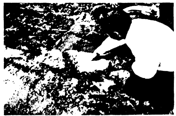
그림 37. 연직배수재 설치직후 배출된 과잉간극수
