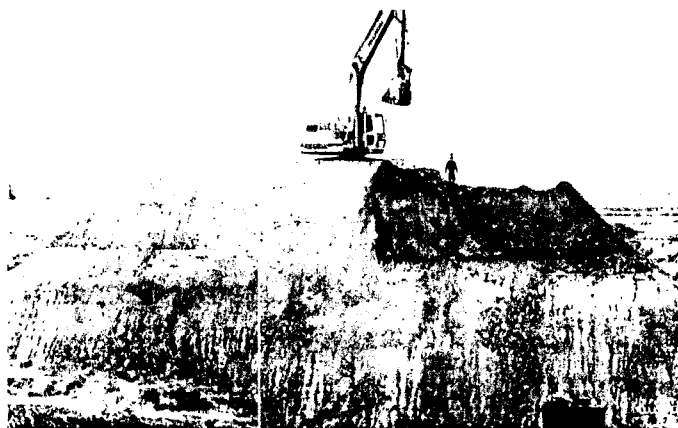
<사진 4.12> 전단파괴 후 성토체 제거 현황
