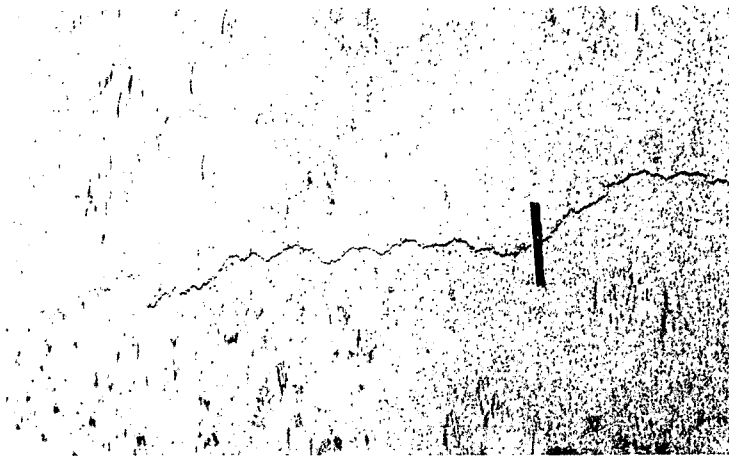
<사진 4.4> 균열 현황 사진 (2)
