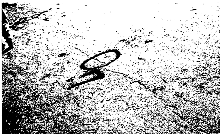
<사진 4.5> 균열 현황 사진 (3)
