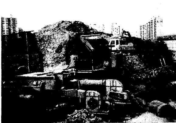
그림 1 사용종료폐기물 굴착 및 선별 과정
