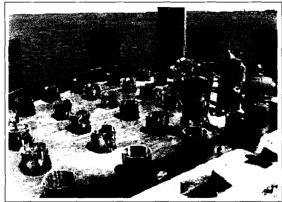
사진 4.4 돌핀에 항타완료된 상태의 복합소재 파일
