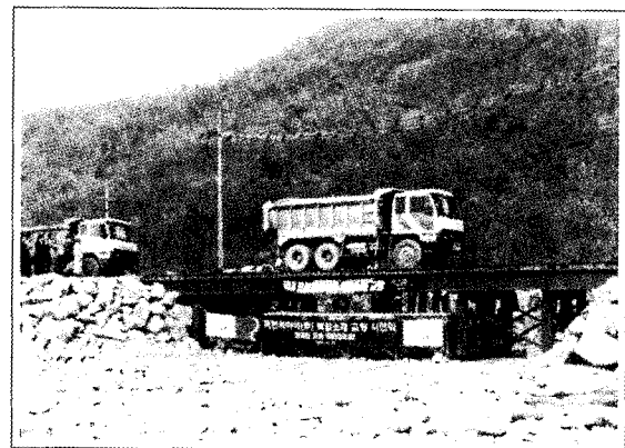
사진 4.20 복합소재 테크 설치후 중차량 통행 모습
