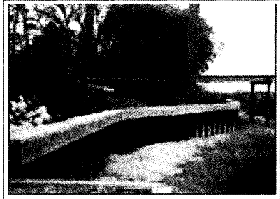
사진 4.10 강재를 복합소재 쉬트파일로 교체시공
