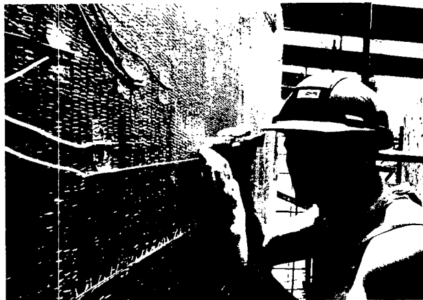
그림 21. GRP 보강판 위에 장광센서 설치 장면.
