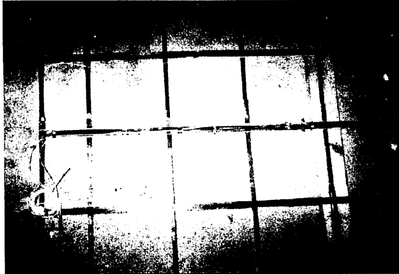
그림 18. 장광센서의 합성 Rebar에 설치.
