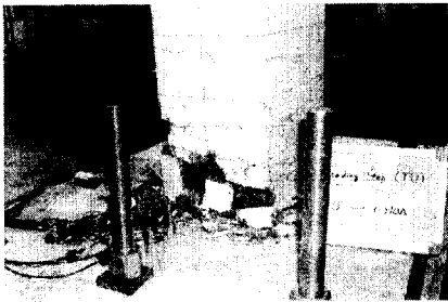
(a) Spalling 발생
