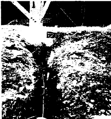
그림 1. 접지 개수공사 장면
