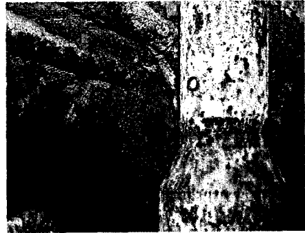
Fig. 5 부식 및 보온재 함몰상태
