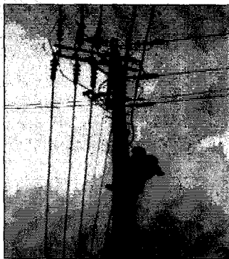
그림 7. 22.9[kV] 배전선 다중접지선의 접지전류 측정 장면
