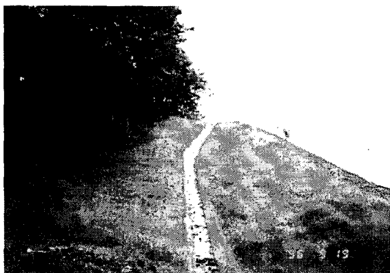
그림 4.3 소단배수로 및 산마루측구 설치예
