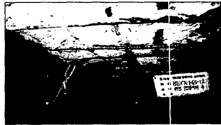
그림 9. 치핑 및 고압세척후 모습
