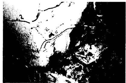
(b) 콘크리트 커버의 스폐링
