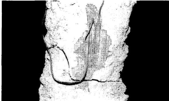
사진2. 철근의 인장응력에 의한 시멘트 그라우팅의 균열
