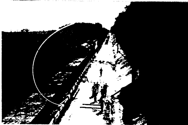
그림 20 하나의 차수매트의 설치
