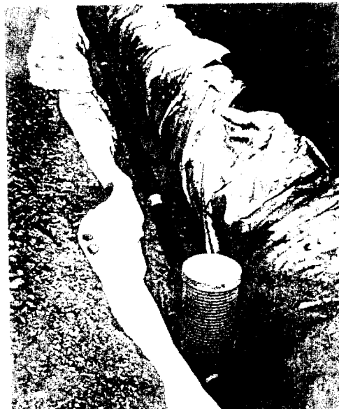
그림 5. 하나의 Trench filter의 건설
