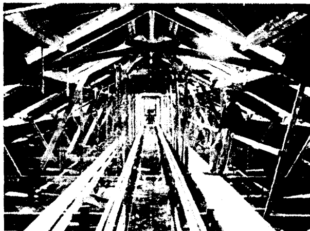
Torquay 탱크의 종방향 전경
