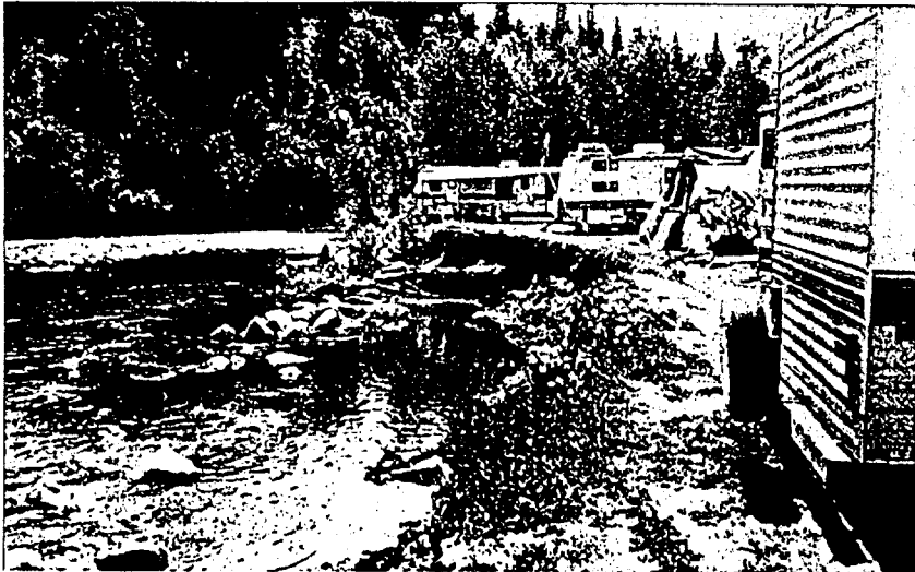
그림 29. 하천 제방이 심하게 세굴된 상태
