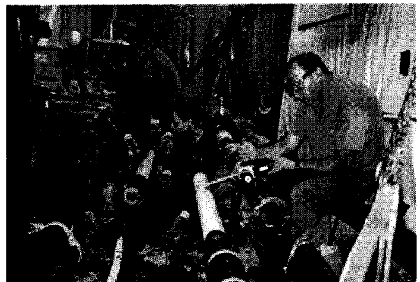
그림 4. 현지 작업자에 의한 PJ 조립
